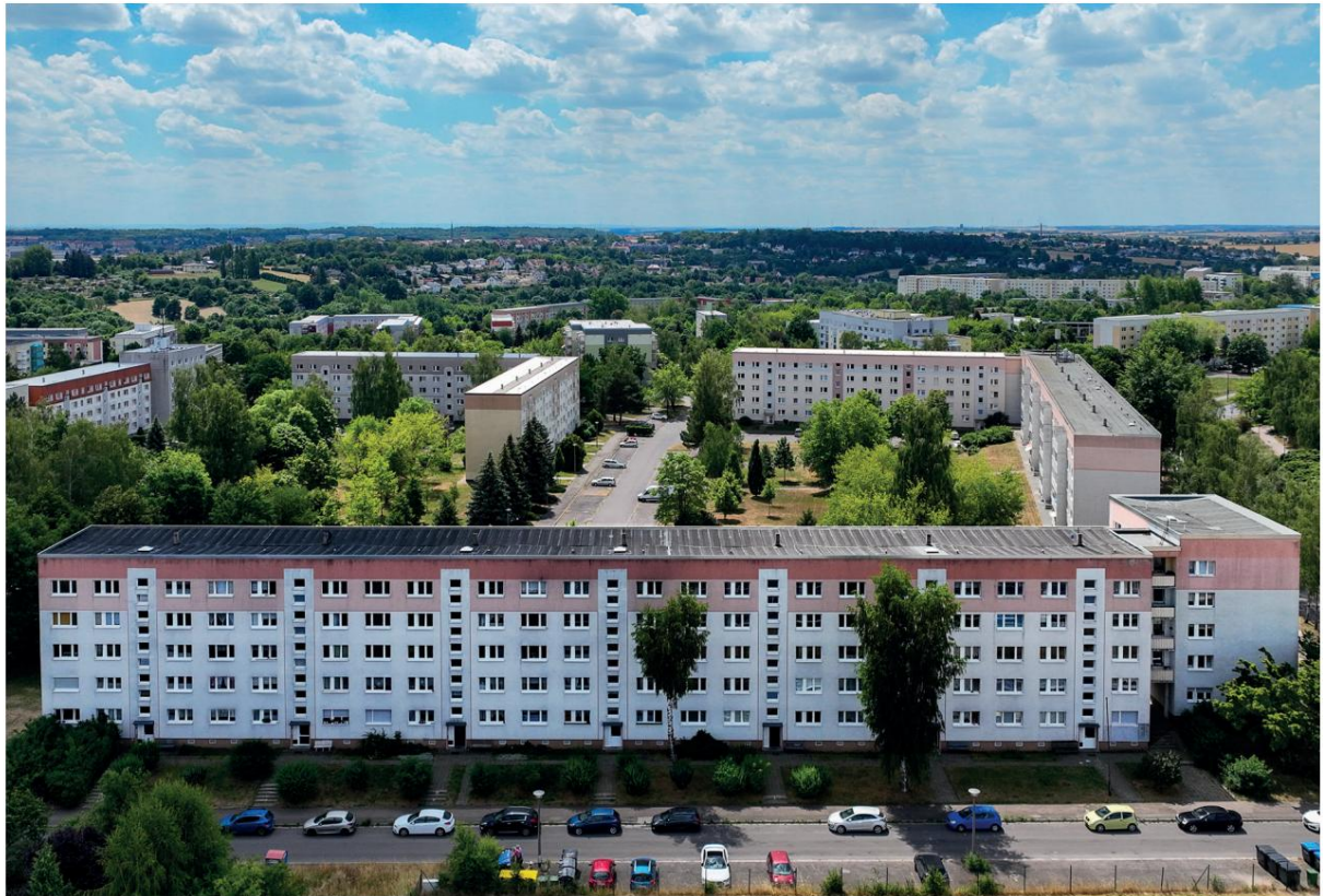
Widok na fasadę dzielnicy Bonhoeffer w Altenburgu
