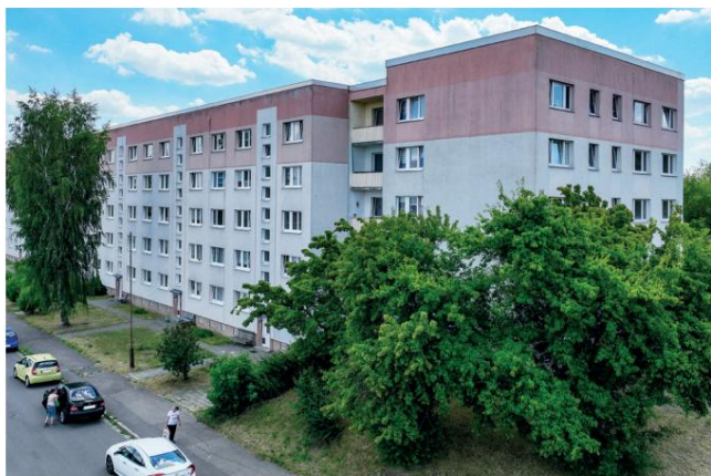
Widok na fasadę dzielnicy Bonhoeffer w Altenburgu
