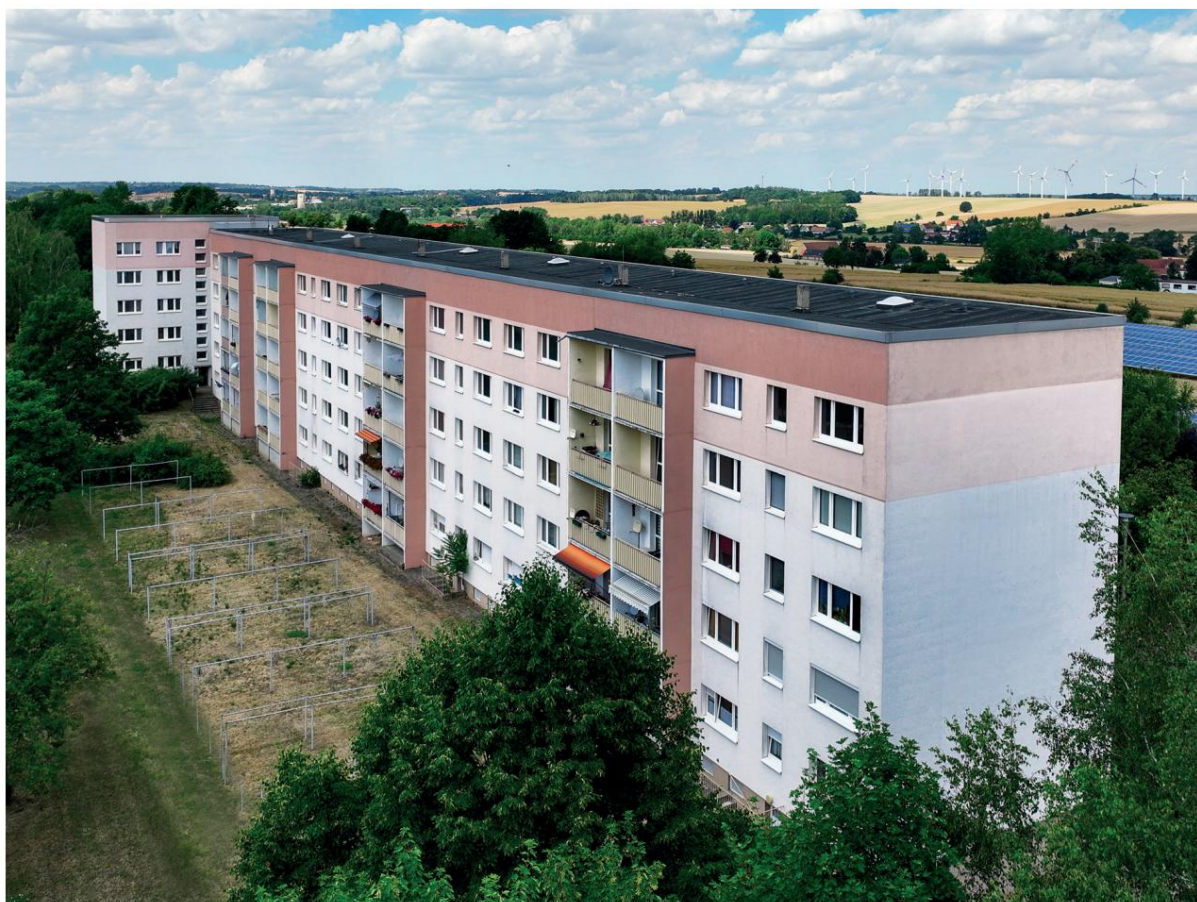
Widok na fasadę dzielnicy Bonhoeffer w Altenburgu
